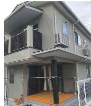
「つむぎ」のウッドデッキ
